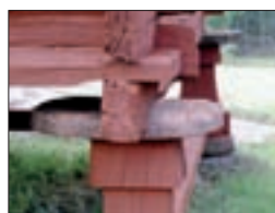
Runda, flata stenar placerade på grundplintarna till sädesmagasin, utgör ett effektivt rättskydd. Populärt kallad rättstopparen.
